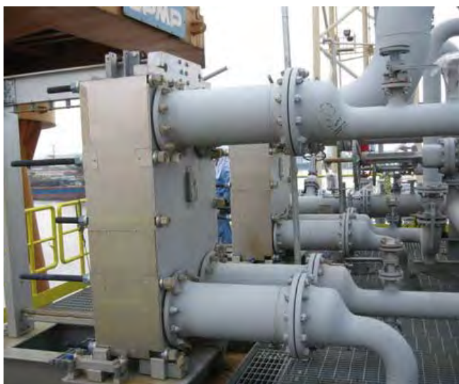
Разборные пластинчатые теплообменники Трантер на борту плавучего нефтекомплекса (Нигерия).
