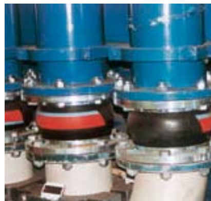
Использование компенсатора типа AS-1 фирмы СТЕНФЛЕКС в системе циркуляции охлаждающей жидкости судового двигателя
