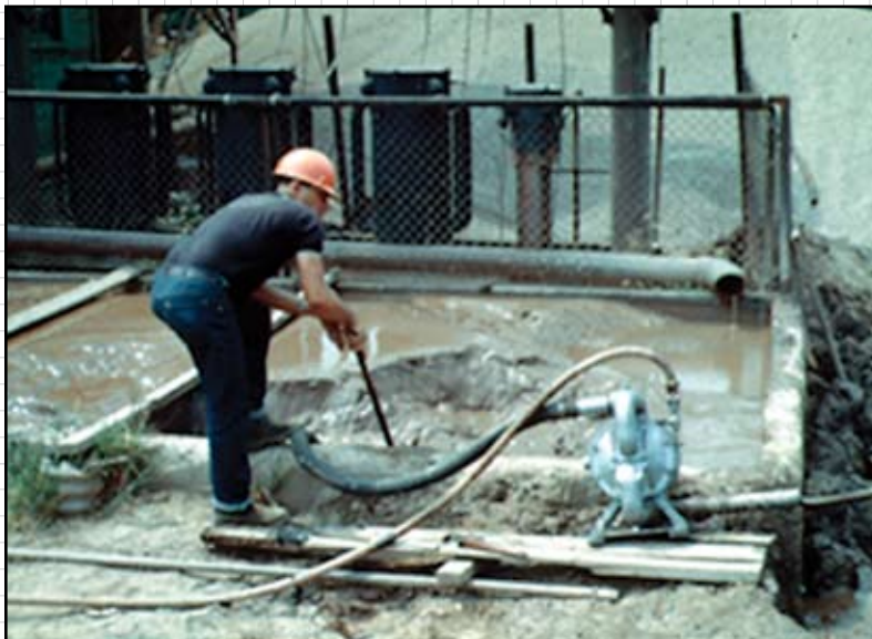
Насос повышенной производительности с откидными клапанами, временно установленный для откачки осадка из отстойника (точная установка в систему не требуется).
