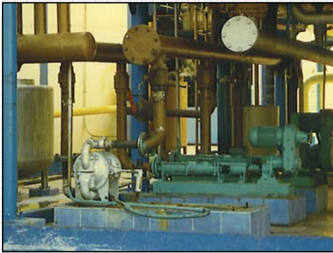
Решение, предусматривающее установку насоса AODD, выбрано с целью снижения полных затрат владельца и минимизации площади размещения.
